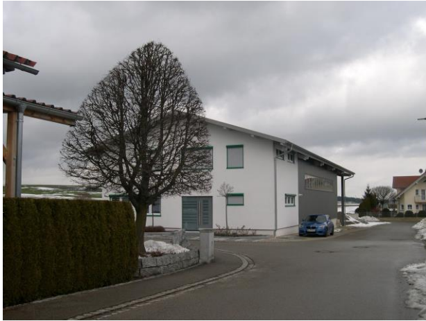
Nordweg, Blickrichtung von Süden nach Norden, Halle und Bürogebäude GaLaBau-Betrieb
